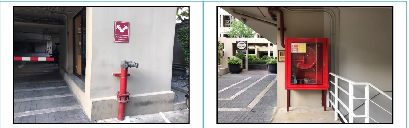
หัวจ่ายน้ำดับเพลิงบริเวณป้อมรถและตู้ดับเพลิงบริเวณทางขึ้น-ลงลานจอดรถชั้นใต้ดิน
